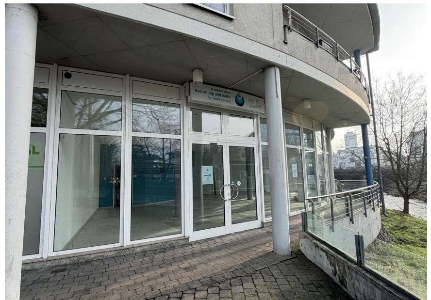
Blick auf den zur Theel orientierten Gebäudeteil
