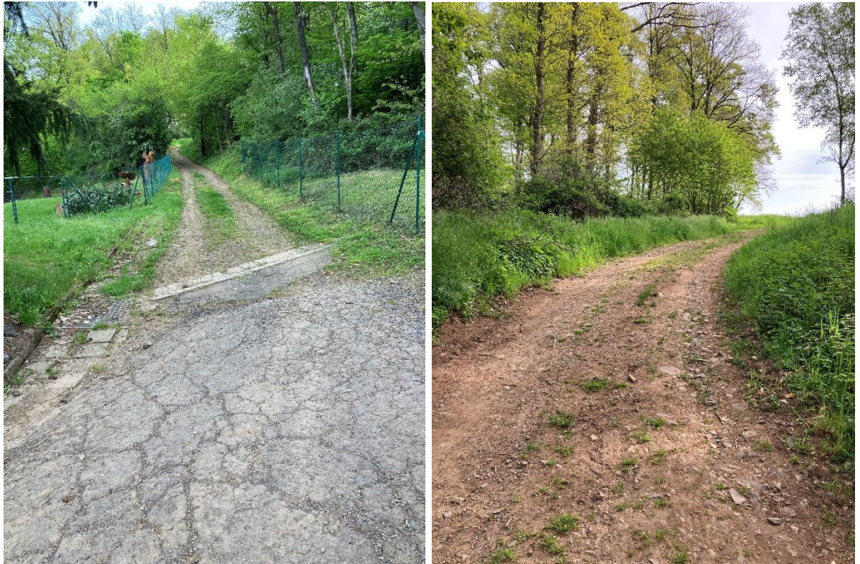
Abb. 32: Rinnen und Einlaufbauwerk "Auf Mess" (P&P GmbH 2022/2023)
