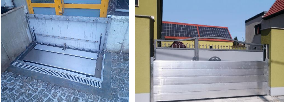
Abb. 10: Klappschottor oder mobiles Dammbalkensystem an Hauseingängen (BMWSB 2022)
