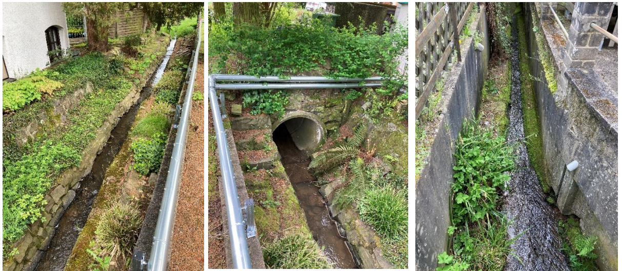
Abb. 58: Durchlass des Mertenfloß an der "Tholexer Straße" (P&P GmbH 2023)
