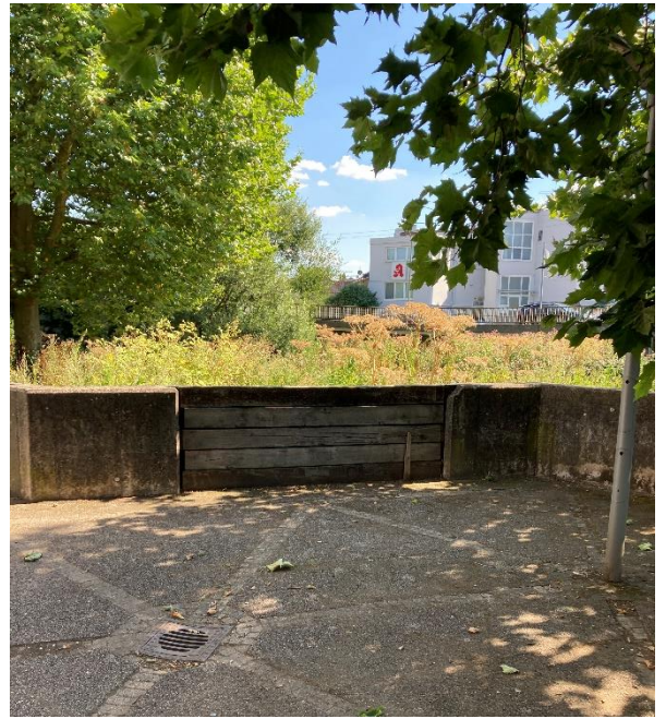
Abb. 61: Dambalkensystem und Hochwasserschutzmauer Lebach (P&P GmbH 2022)
