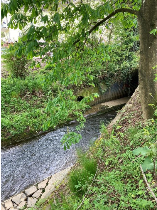
Abb. 28: Durchlassbauwerk der Theel in der Mühlenstraße (P&P GmbH 2023)
