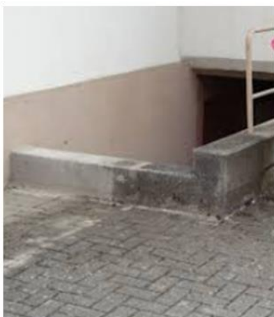
Abb. 9: Aufkantung zur Wasserlenkung an einem Kellereingang (GDV 2021)
