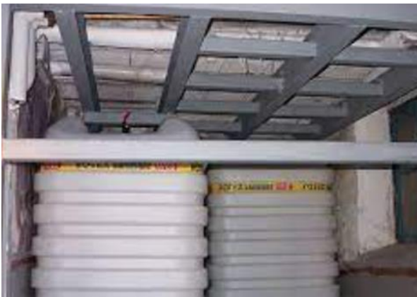
Abb. 11: Sicherung Heizöltanks (BMWSB 2022)
