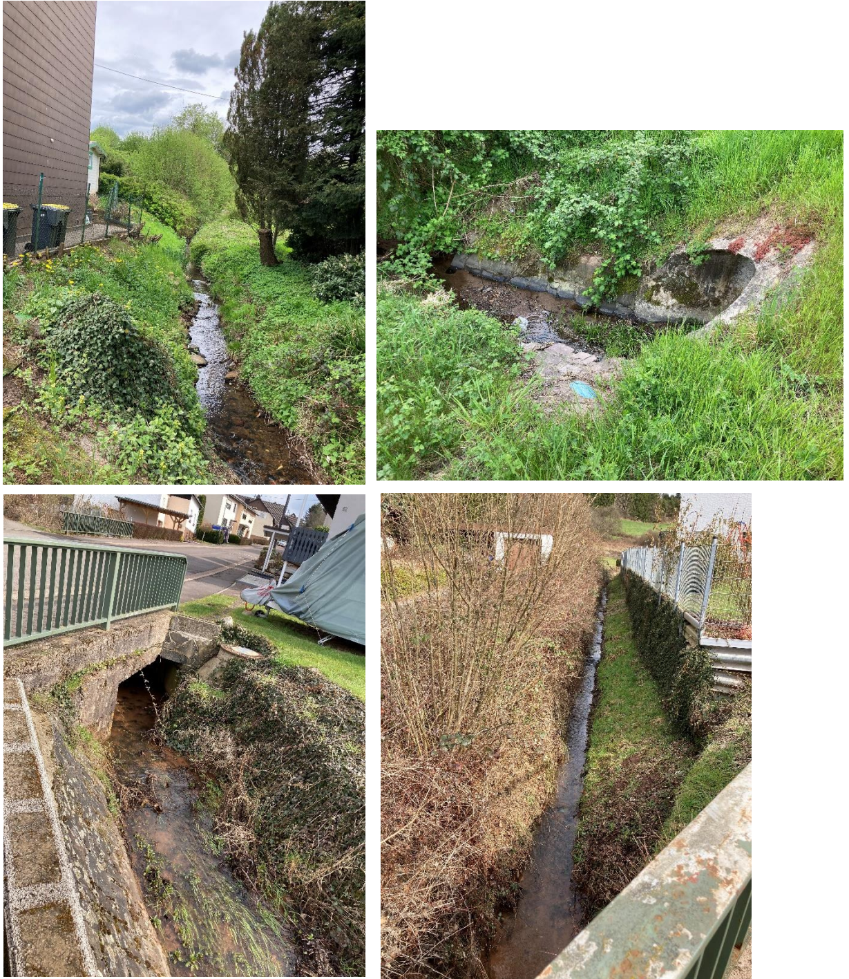
Abb. 29: Durchlassbauwerke Krebsbach (oben) und Schellenbach (unten) (P&P GmbH 2022)
