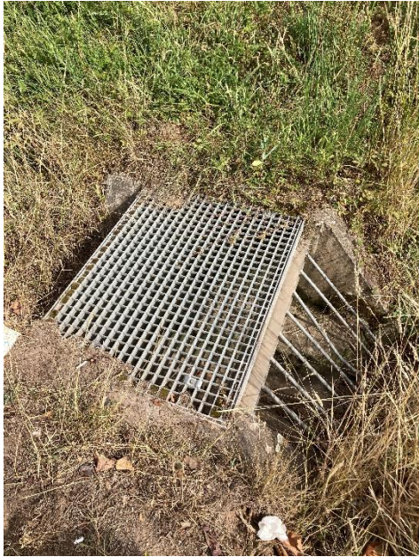
Abb. 60: Einlaufbauwerk zur Entwässerung (P&P GmbH 2022)
