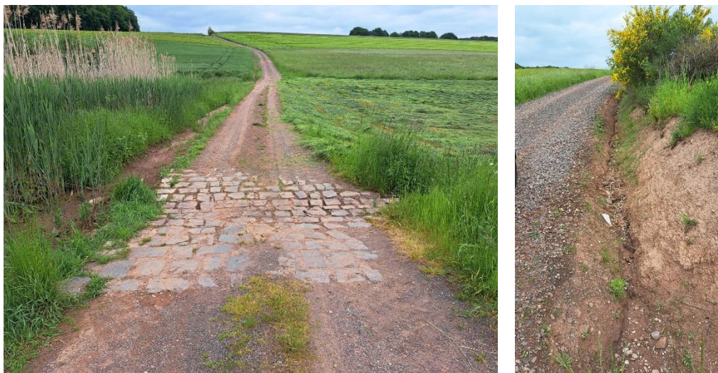
Abb. 39: Furt und Entwässerungsgraben am Biedelsbach (P&P GmbH 2023)
