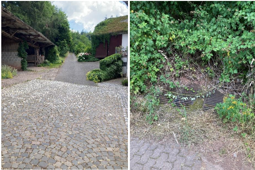
Abb. 63: Wirtschaftsweg und Einlaufbauwerk Körpricher Straße (P&P GmbH 2022)
