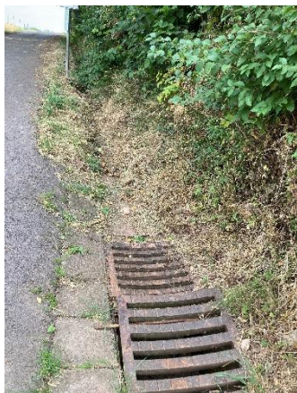
Abb. 50: Einlaufschächte und Entwässerungsgräben der Habacher Straße (P&P GmbH 2022)
