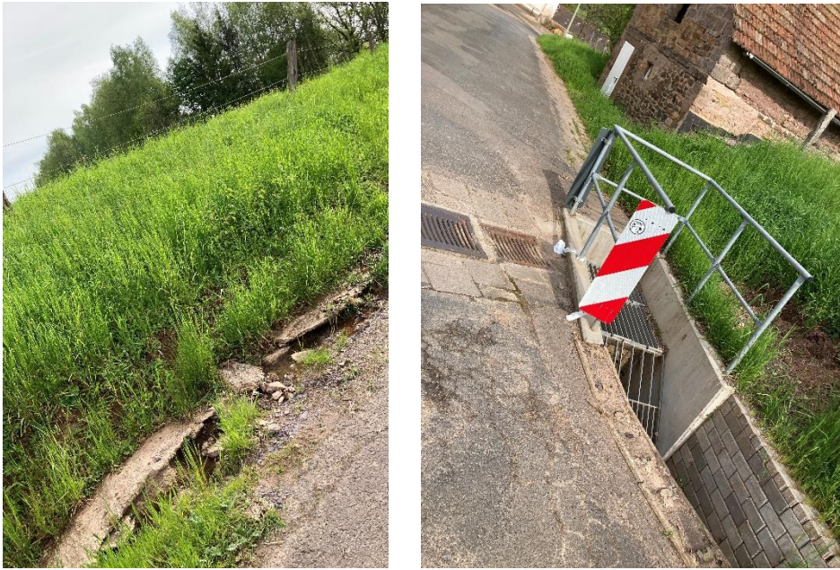
Abb. 40: Hügelstraße Entwässerungsrinne und Einlaufbauwerk (P&P GmbH 2022)
