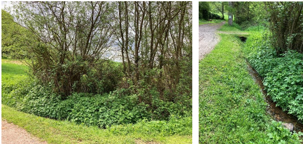
Abb. 64: Neu angelegter Entwässerungsgraben in der Zollstockstraße (P&P GmbH 2023)
