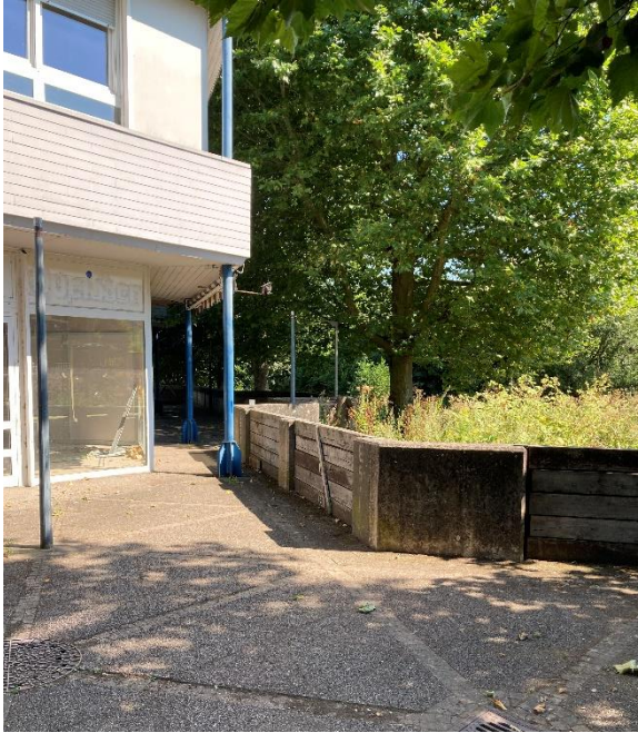
Abb. 61: Dambalkensystem und Hochwasserschutzmauer Lebach (P&P GmbH 2022)
