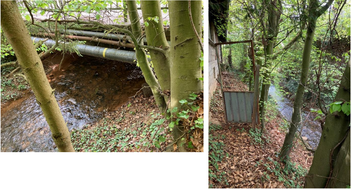
Abb. 57: Einlauf in das Durchlassbauwerk an der "Saarbrücker Straße" (P&P GmbH 2022)
