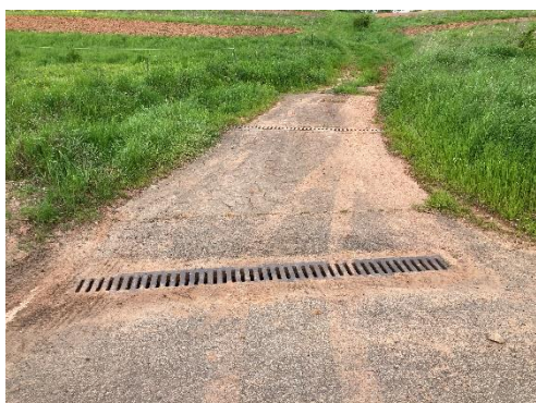
Abb. 47: Durchlassbauwerke Roßbach und Zulaufgraben „Langwertbach“ zum Roßbach (P&P GmbH 2022/2023)
