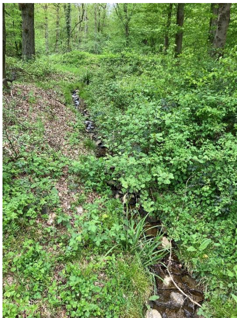
Abb. 23: Ablauf aus dem RRB „Etzelbach“ (P&P GmbH 2023)
