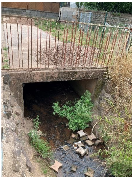
Abb. 49: Durchlassbauwerk am Osbach (P&P GmbH 2022)
