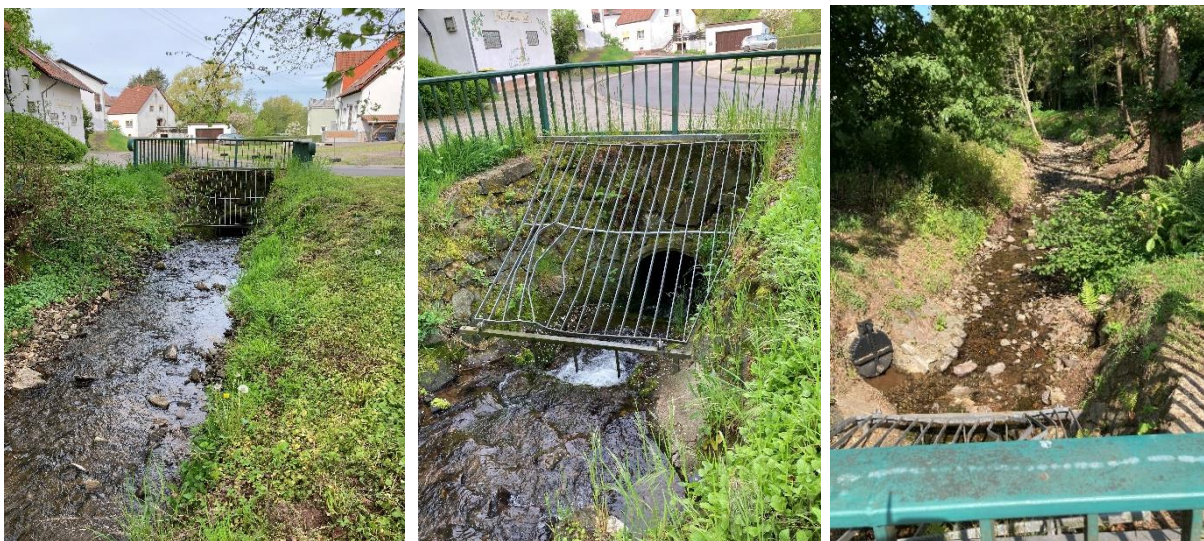
Abb. 33: Saubach und Durchlass Rotheckstraße (P&P GmbH 2023)
