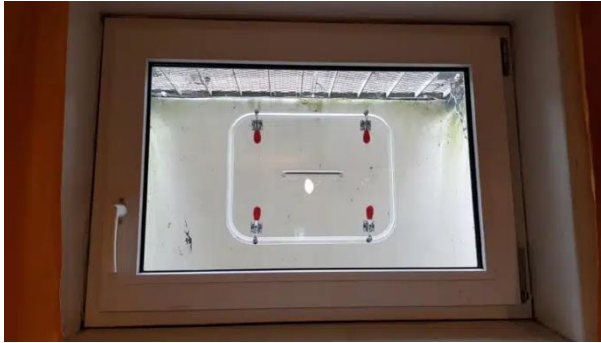
Abb. 13: Druckwasserdichte Kellertür (HWS-Profis 2023)
