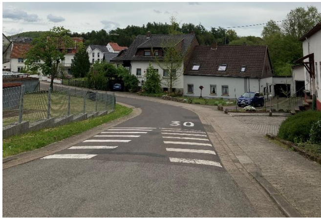
Abb. 22: Straße und Rinne "In der Au" (P&P GmbH 2023)
