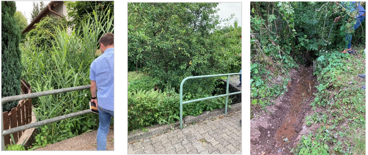
Abb. 56: Durchlassbauwerk Hahnerbach in der Mottener Straße (P&P GmbH 2022)
