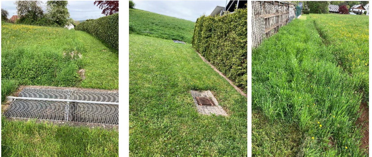
Abb. 37: Entwässerungsgräben und Einlaufbauwerke Rotheckstraße / Römerstraße (P&P GmbH 2022)
