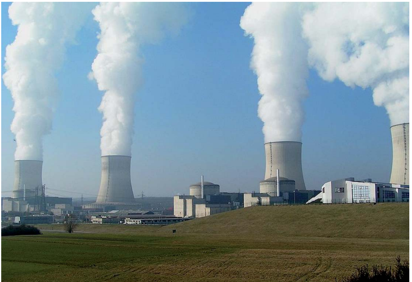
Anlass für Bedenken: Kernkraftwerk Cattenom
