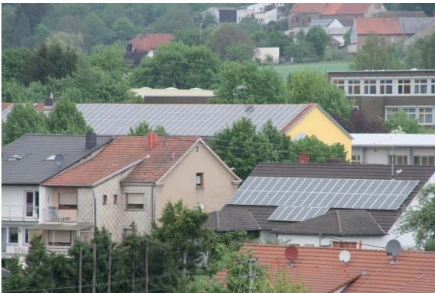
Mit gutem Beispiel voran: Viele, teilweise große Solardachflächen gibt es auch in Lebach. Beispielsweise auf dem Dach der städtischen Grundschule St. Michael (gelbes Gebäude im Hintergrund)
