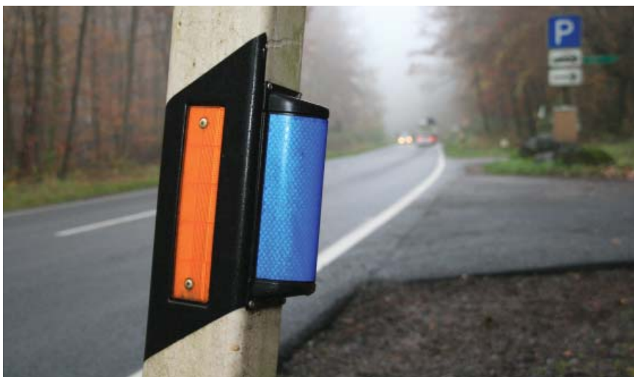
Vorbeuge vor Wildunfällen: Mit blauen Reflektoren nachgerüstete Seitenpfosten
