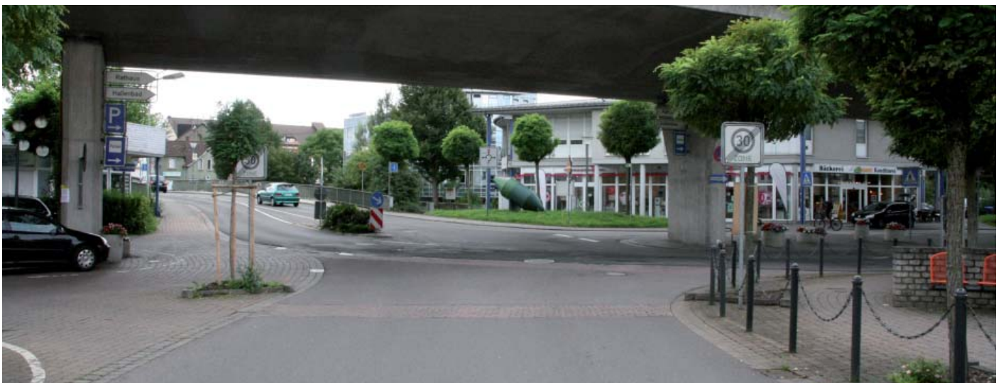
Problematische Vorfahrtsregelung mit neun Zu- und Abfahrten: Kreuzung Marktstraße / Am Markt
