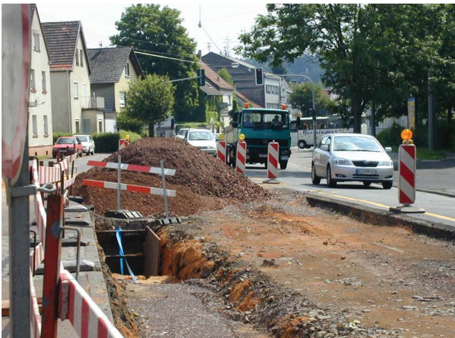
Verbessern die Infrastruktur: Arbeiten an Lebacher Straßen
