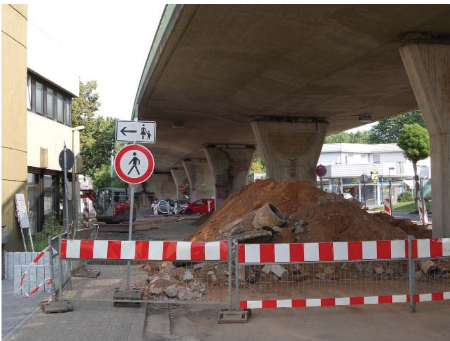
Bau hat begonnen: Arbeiten am Minikreisel Am Markt
